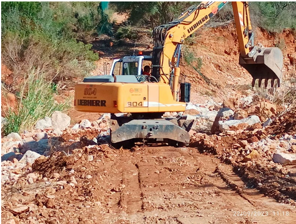
Treballs d'arranjament de camins afectats per la DANA a Freginals.
