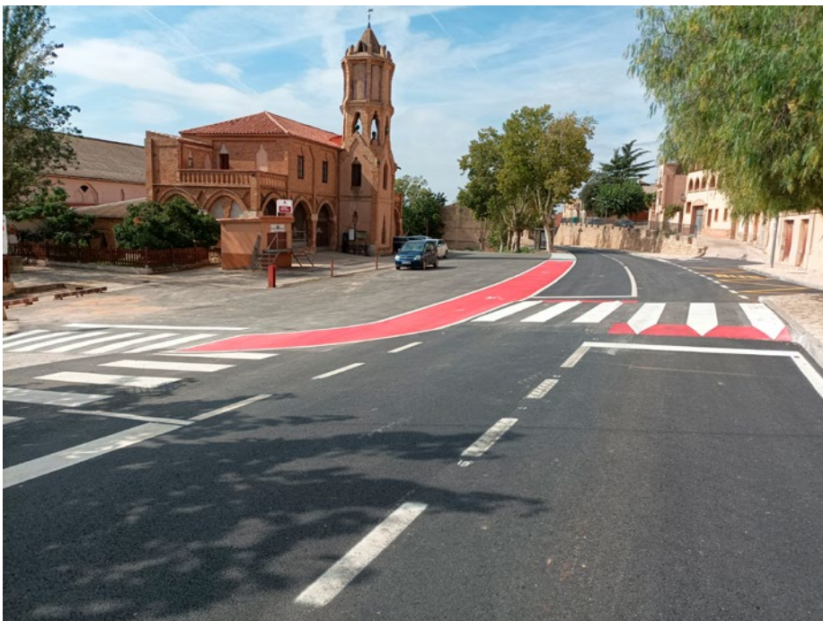
Renovació de la senyalització horitzontal.
