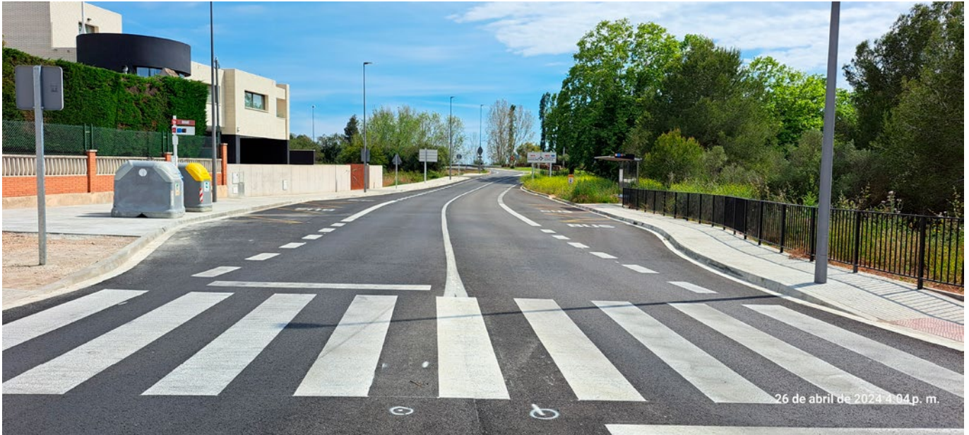
Condicionament de la carretera TP-2039 a l'N-340. Tram T-203 a N-340. TM de Tarragona i el Catllar.
