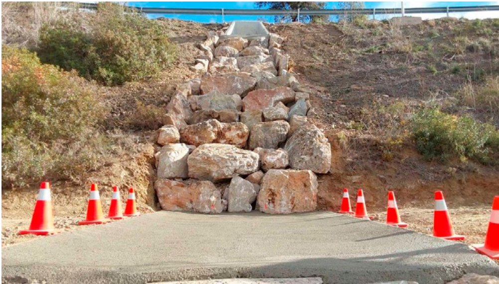
Millora del drenatge a la carretera TP-7403.
