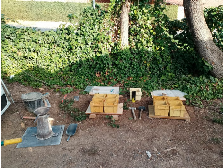
Preses de mostra de formigó dels fonaments del nou pont.
