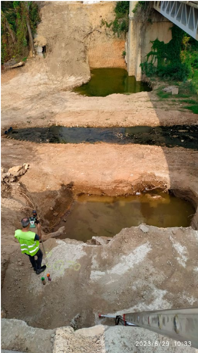
Comprovació de la construcció del pont TP-2003. Vila-rodona..
