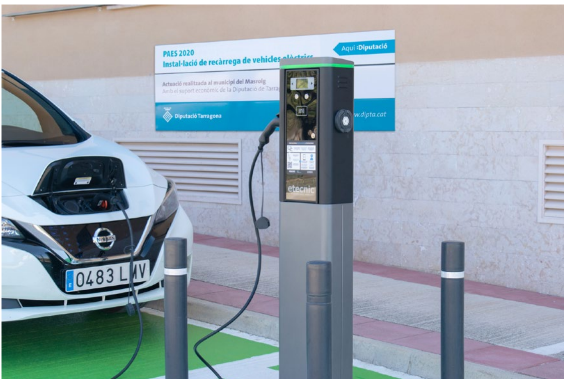
Direcció de l'obra i coordinació de seguretat i salut de la instal·lació d'una nova estació de recàrrega per a vehicles elèctrics.
