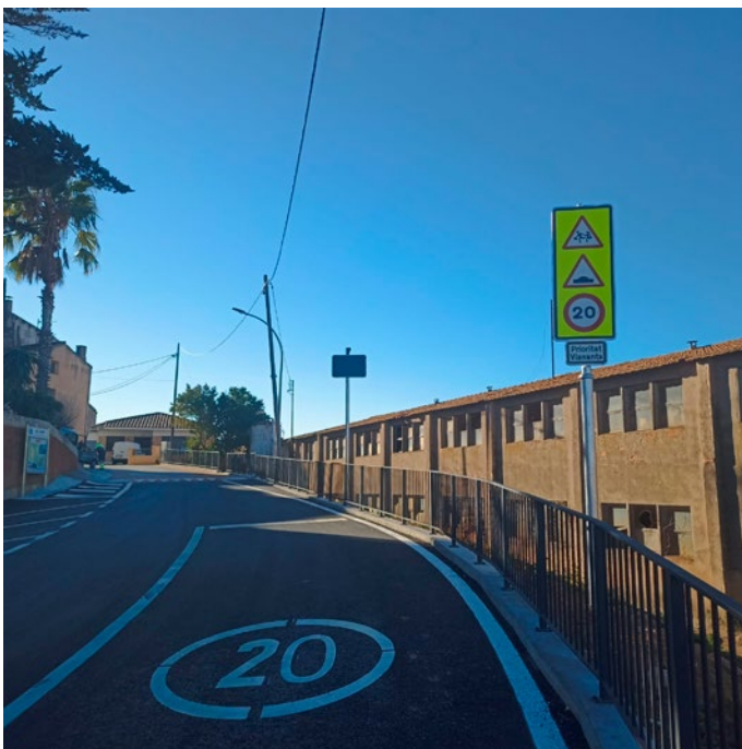
Condicionament d'un tram de la travessera.
