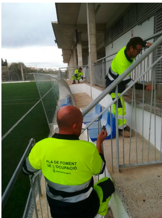
Manteniment de les instal·lacions del camp de futbol a Batea.
