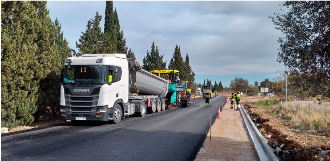
Condicionament de la carretera T-342, de Roquetes als Reguers.
