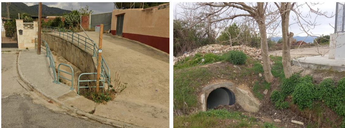
Figura 12. Torrent i petit desguàs d'escorreguda superficial afectats amb les obres projectades
