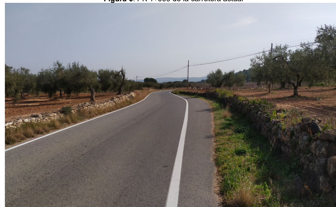
Figura 7. PK 1+300 de la carretera actual amb presència murs pedra seca i suport de Telefònica al fons afectat per la nova traça
