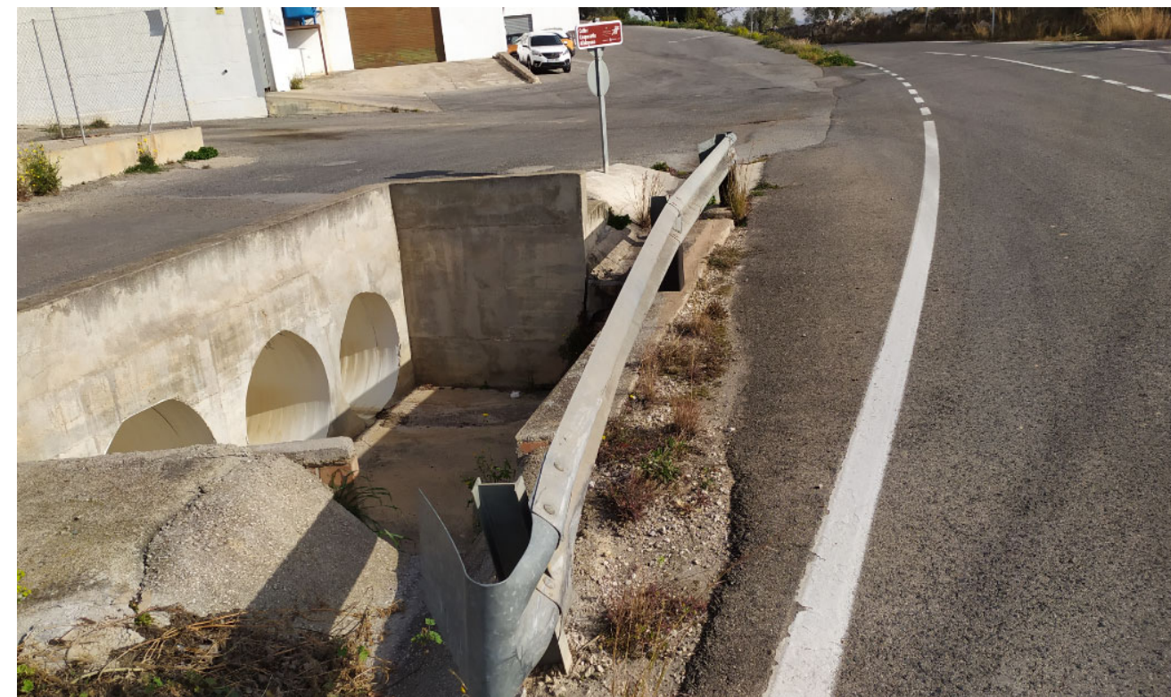
Figura 3. Obra de fàbrica existent ubicada al PK 0+720
