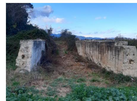
Al tram 6, en concret al PK 26+827 existeix una paret d'un tancament (sense coberta) a base de blocs de formigó. El volum d'enderroc d'aquesta part afectada s'ha d'afegir al als 40 metres linials de la canaleta de reg de totxana de 0,4 metres d'alçada i 0,3 d'amplada.
