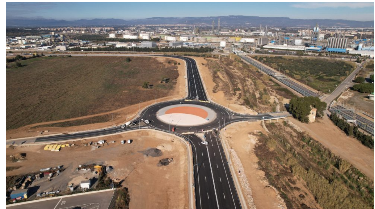
Imatge 1. Fotografia aèria del nou vial perimetral d'accés a la futura ZAL del Port de Tarragona (febrer de 2023).
