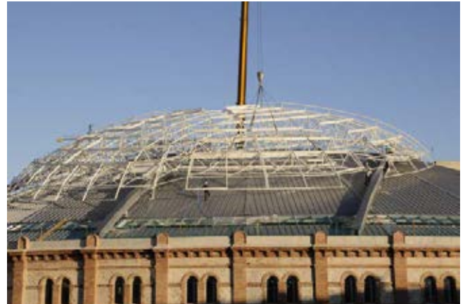
Tarraco Arena Plaça. Obres a la cúpula retràctil, 2016-2017 (AGDT, Fons d'Imatges, ref. "Edificis i centres de la Diputació").
