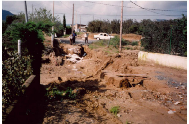
Efectes de la riuada, Alforja, 1994 (AGDT)
