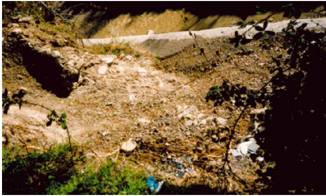
Efectes de la riuada, Porrera, 1994 (AGDT)
