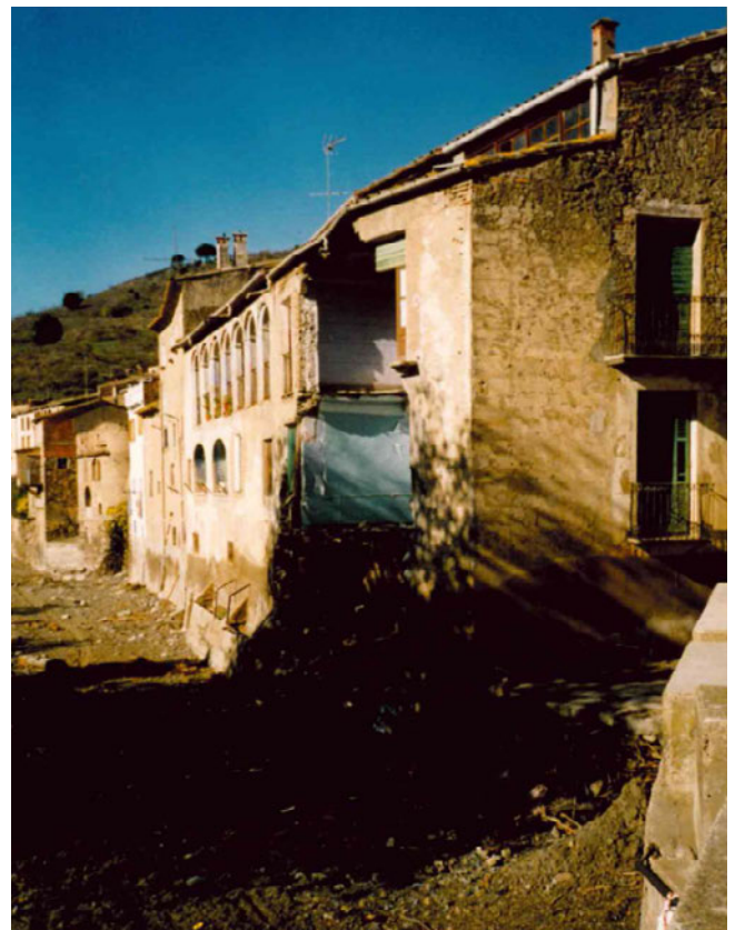
Efectes de la riuada, Porrera, 1994 (AGDT)
