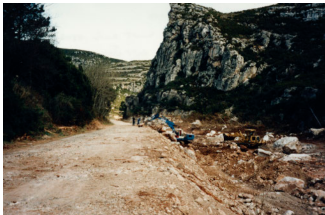
Reconstrucció de mur amb escullera i de tram de carretera desaparegut entre la Riba i Farena (TV-7044), 1994 (AGDT22378)
