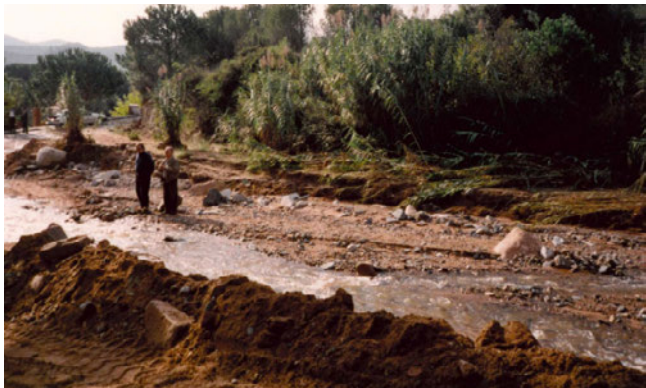
Efectes de la riuada, Alforja, 1994 (AGDT)
