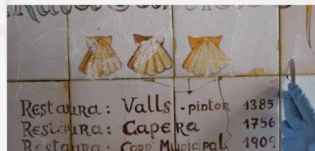
Tancament de fissures
