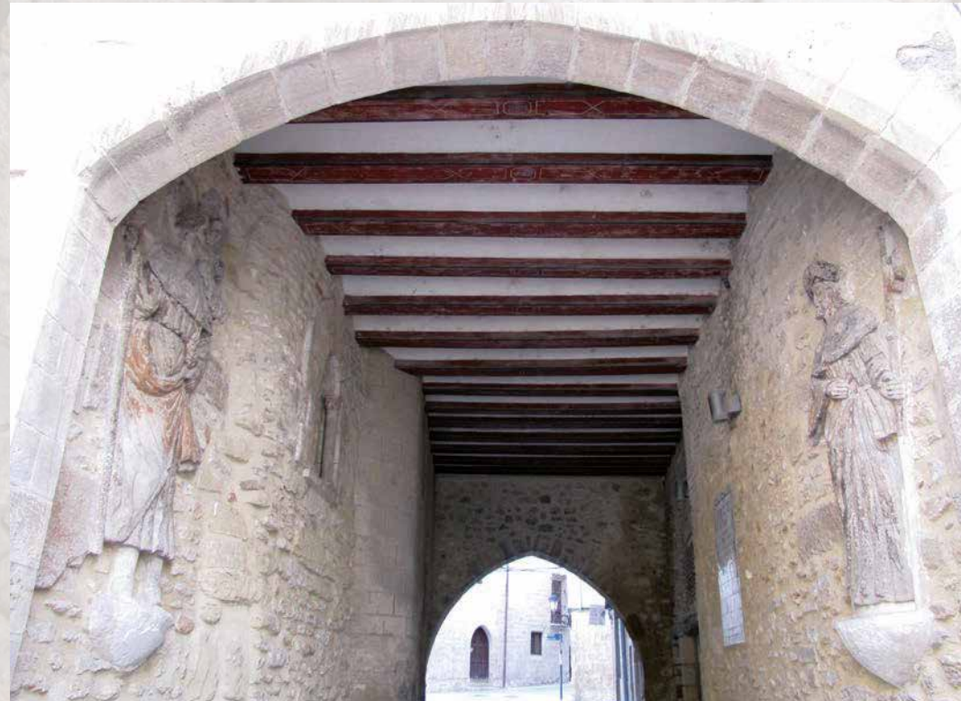
Portal del Romeu després de la intervenció
