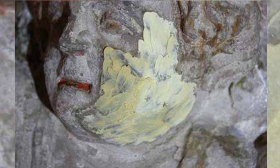
Eliminació de les capes que estaven damunt de l'original
