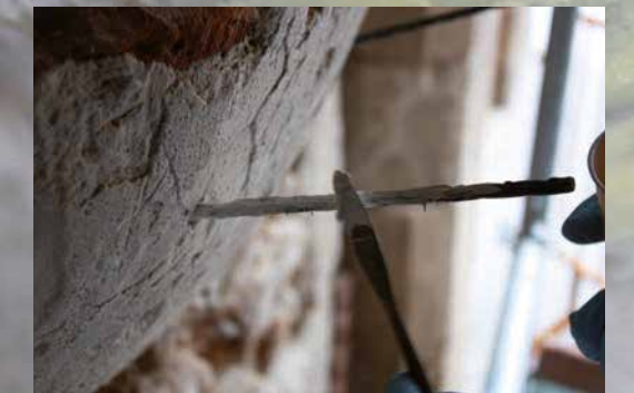
Cosit dels fragments separats del suport
