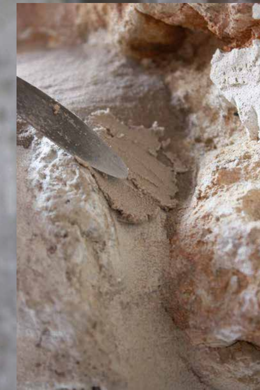
Farciment del perímetre: segellat
