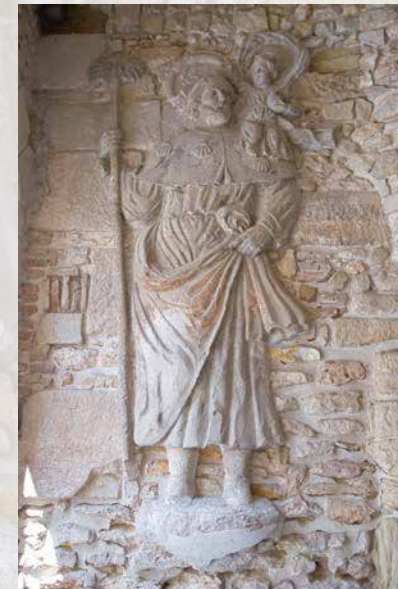
Relleu de Sant Cristòfol abans de la restauració
