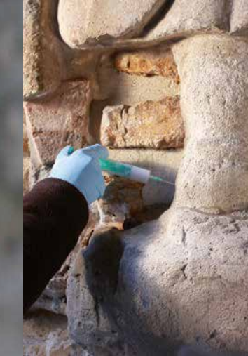
Injecció per al farciment dels buits
