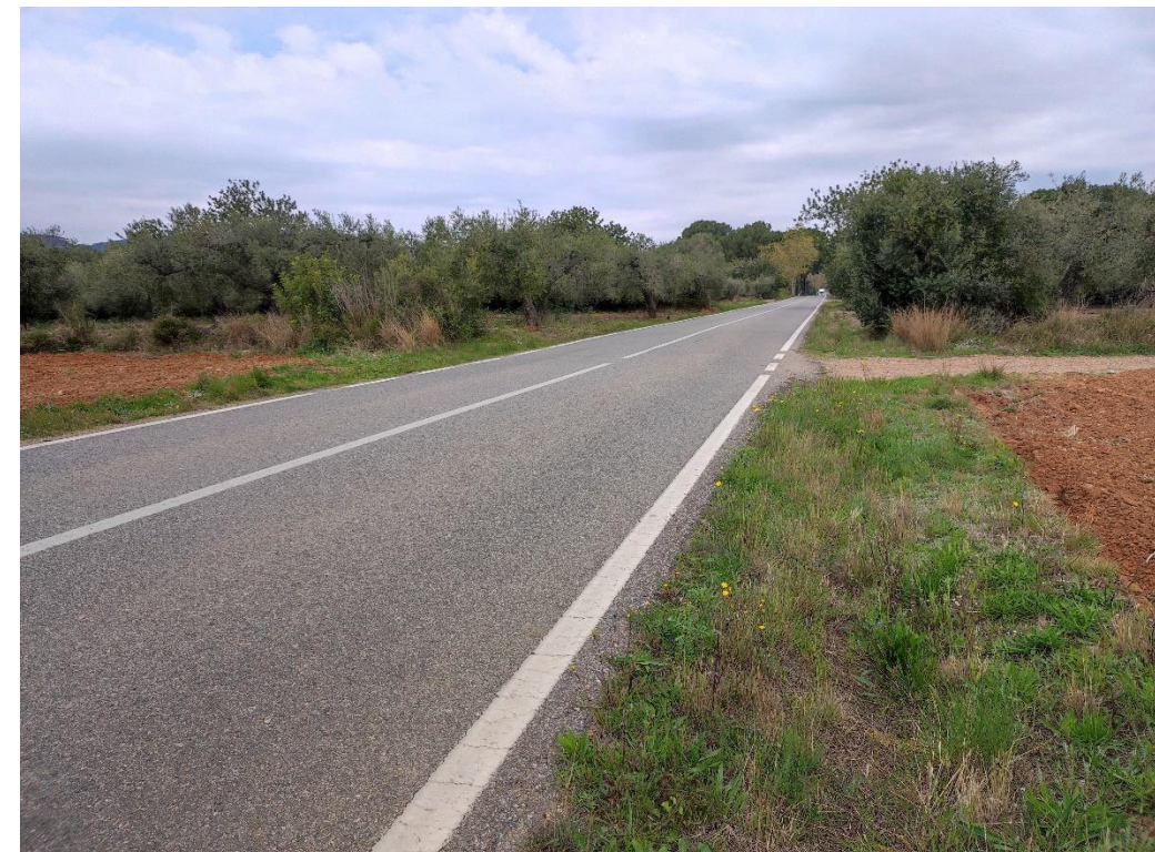
Figura 11. Vista general de la T-321 al PK 0+500
