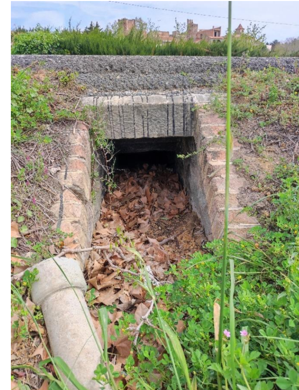
Figura 22. Obra de drenatge transversal a la Intersecció entre la T-321 i l'accés a la població de l'Arbocet
