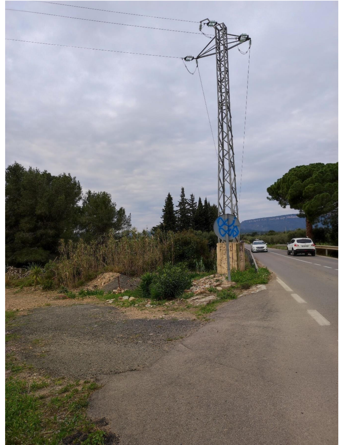
Figura 3. Torre metàl·lica propera a la carretera, a l'inici del projecte
