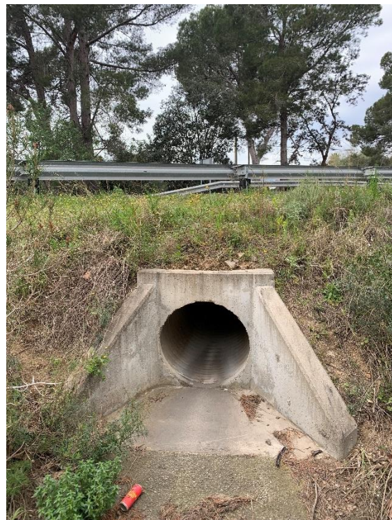
Figura 33. Obra de drenatge transversal a l'alçada PK 2+360
