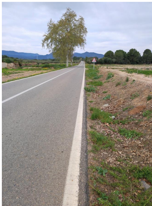
Figura 9. Cuneta de terra a la T-321 al PK 0+050 de la carretera
