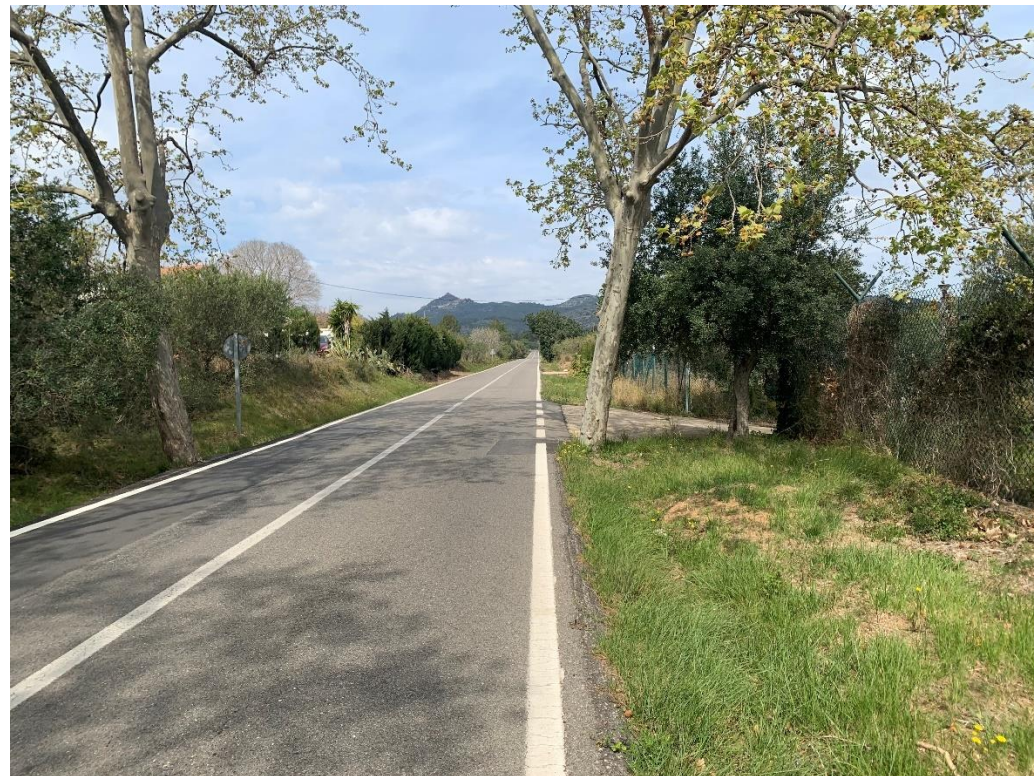
Figura 24. Vista general del vial i proximitat dels arbres al PK 1+440
