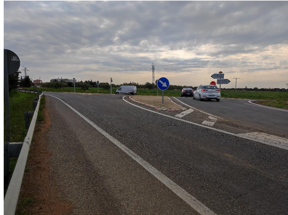
Figura 1. Vista de l'inici del tram de la T-310z
