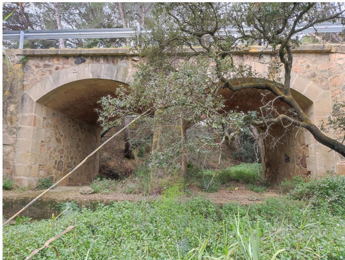
Figura 12. Estructura existent sobre la riera de la Font, al PK 0+710 de la T-321
