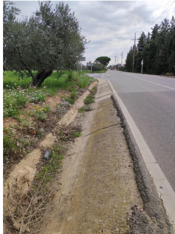
Figura 8. Cuneta triangular transitable existent a la T-310z, entre els PK 13+900 i 13+400
