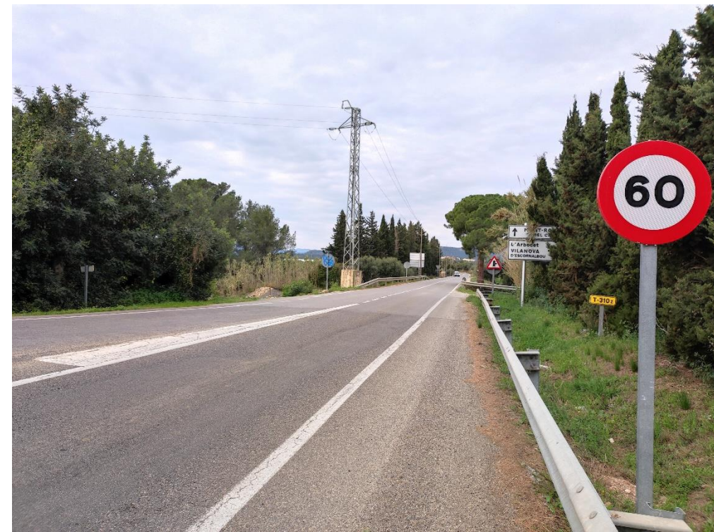
Figura 2. Vista general de l'inici del tram de la T-310z
