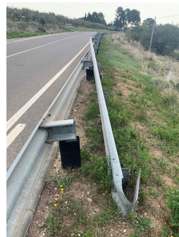
Figura 30. Finalització de barrera en "cua de piex" al PK 2+235
