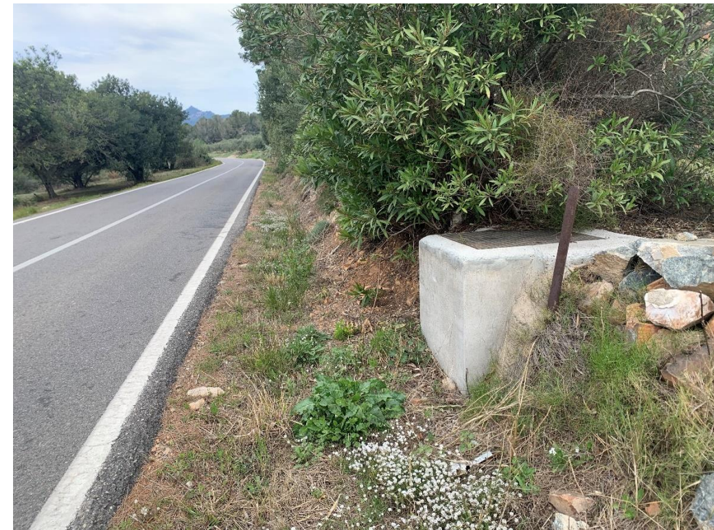
Figura 26. Estructura de formigó al PK 2+000
