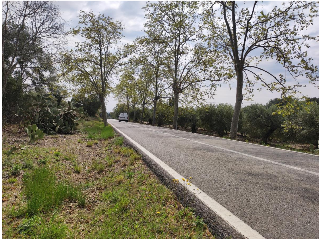
Figura 20. Vista general del vial i proximitat dels arbres al PK 1+260
