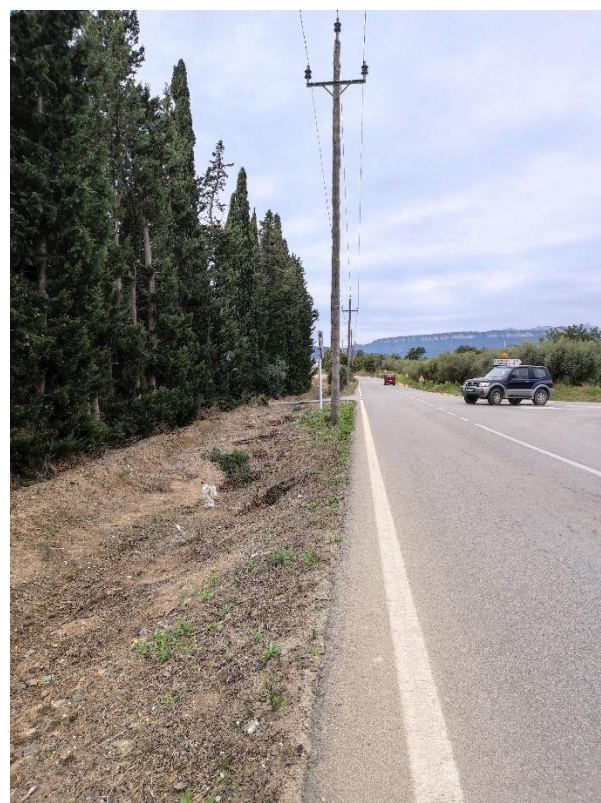
Figura 5. Pals de fusta de la línia de mitja tensió propera a la T-310z, a l'alçada de la intersecció entre la T-310z i T-321
