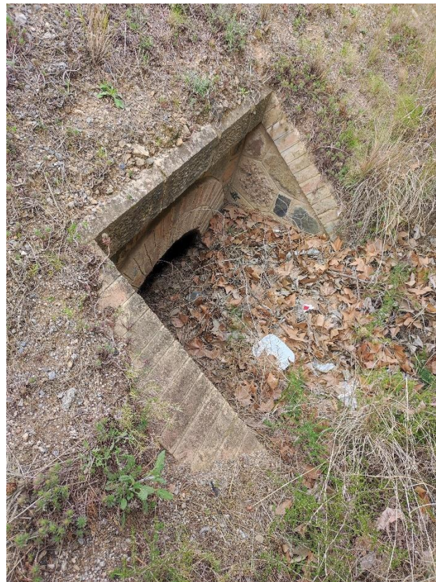
Figura 17. Obra de drenatge transversal al PK 1+075
