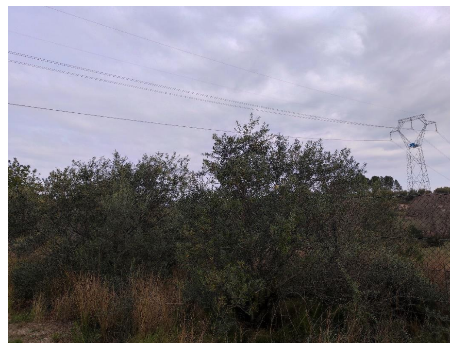
Figura 15. Línia aèria de mitja tensió al PK 1+015
