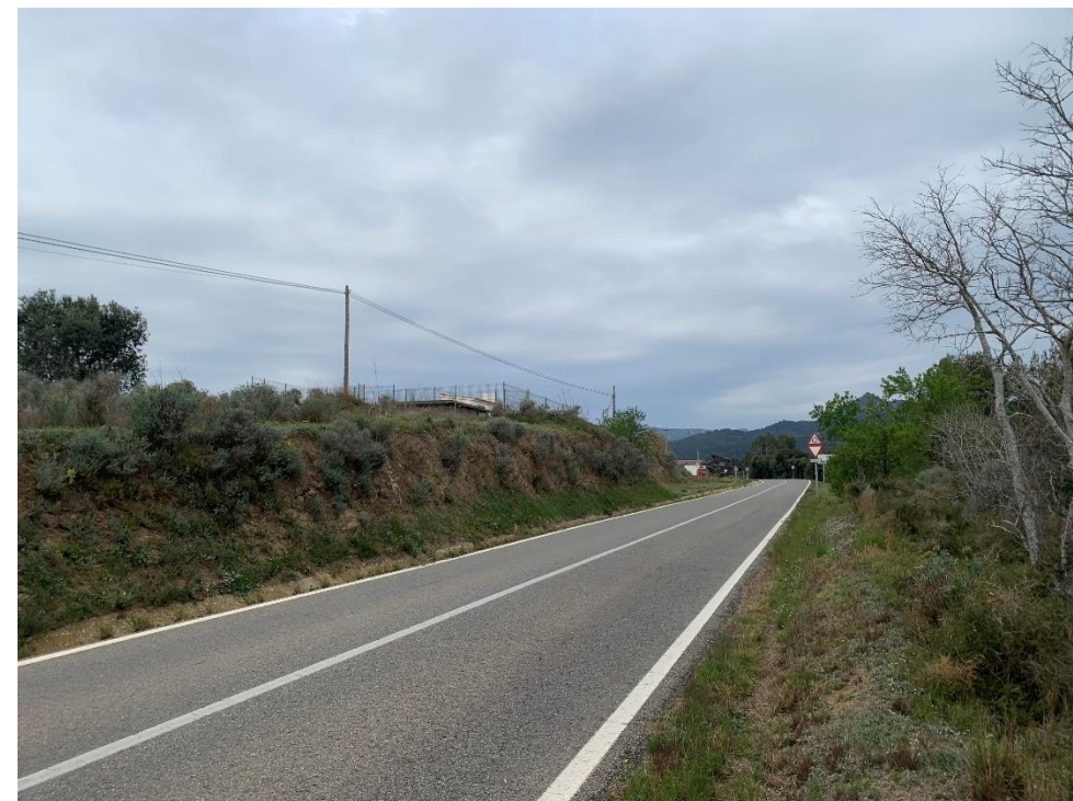
Figura 35. Vista general del vial i línia aèria de telefonia a la vorada esquerra al PK 2+500
