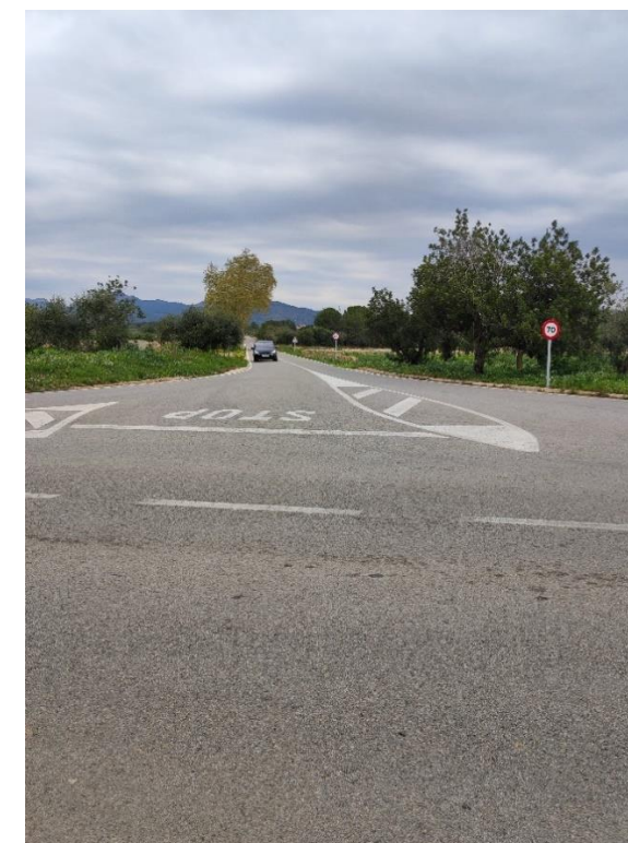
Figura 6. Intersecció entre les carreteres T-310z i T-321
