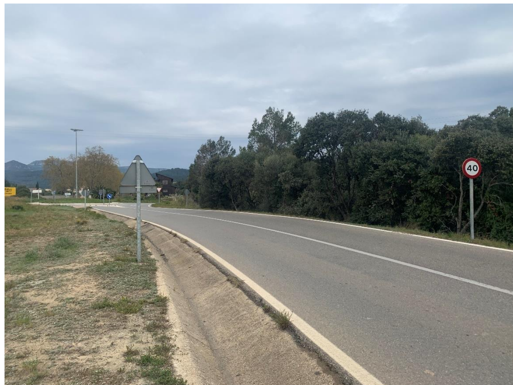
Figura 36. Vista general del vial i cuneta de formigó a la vorada esquerra al PK 2+660
