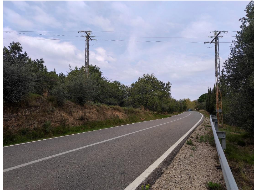
Figura 16. Vista general del vial i línia aèria de mitja tensió que creua al PK 1+040
