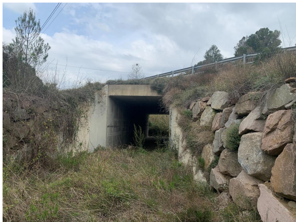
Figura 29. Calaix de formigó que travessa la T-321 al PK 2+230
