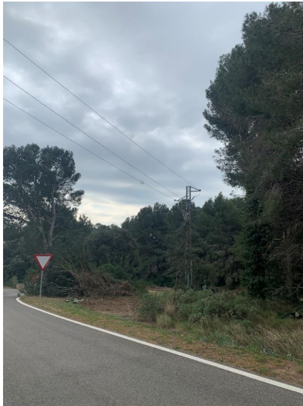
Figura 32. Línia aèria de mitja tensió a l'alçada PK 2+275
