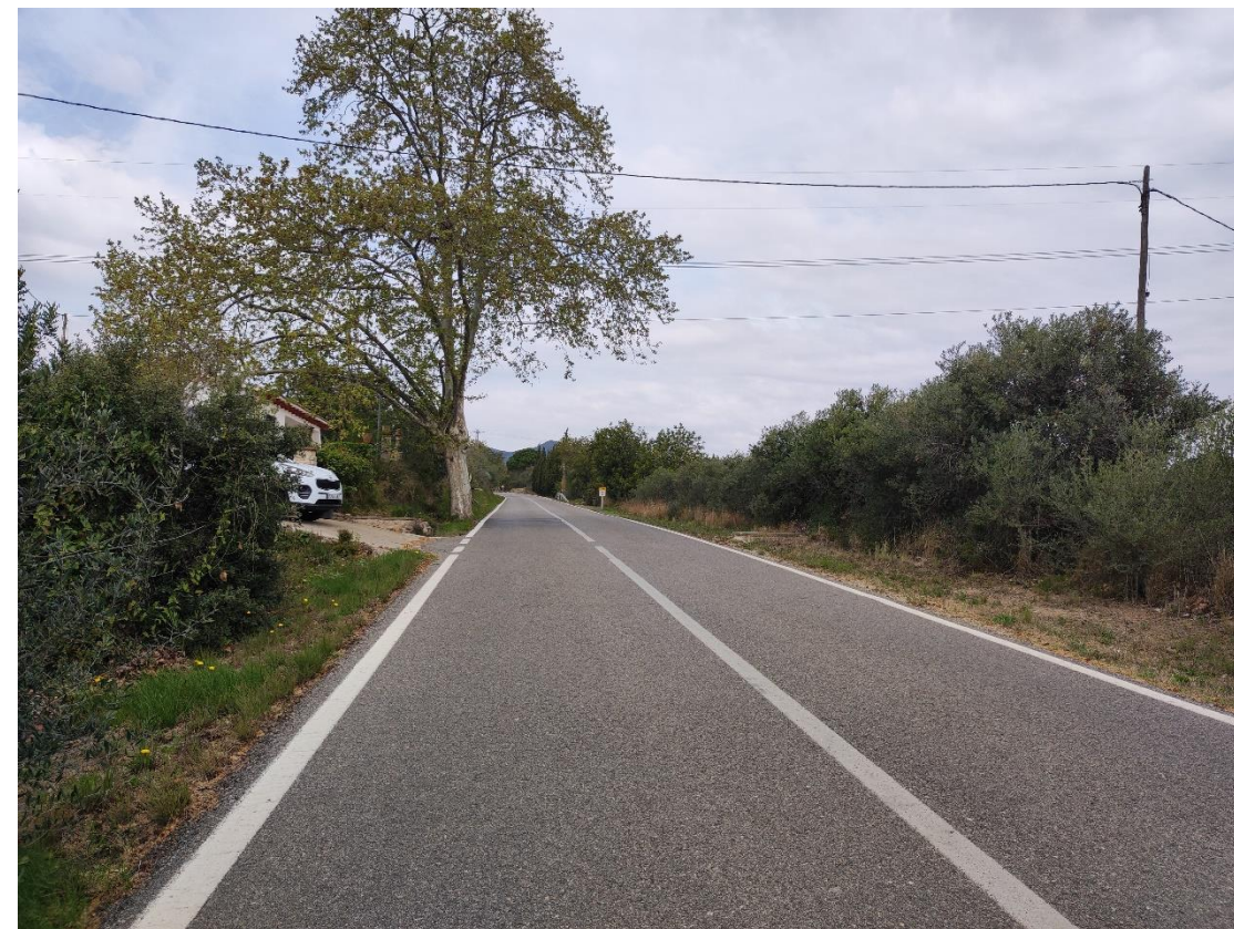
Figura 14. Línia aèria de baixa tensió que creua la T-321 al PK 0+950
