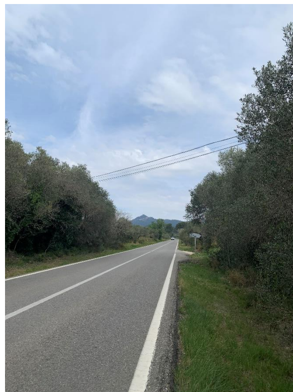
Figura 25. Línia aèria de telefonia a l'alçada PK 1+730
