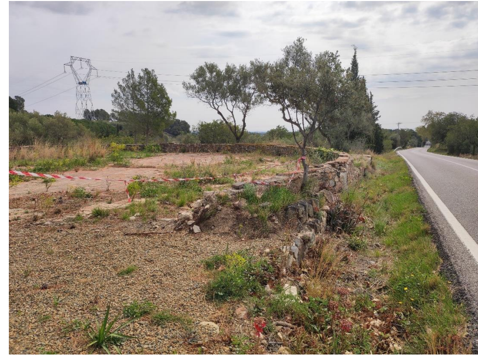
Figura 18. Construcció a la vorera dreta de la T-321 a l'alçada PK 1+130
