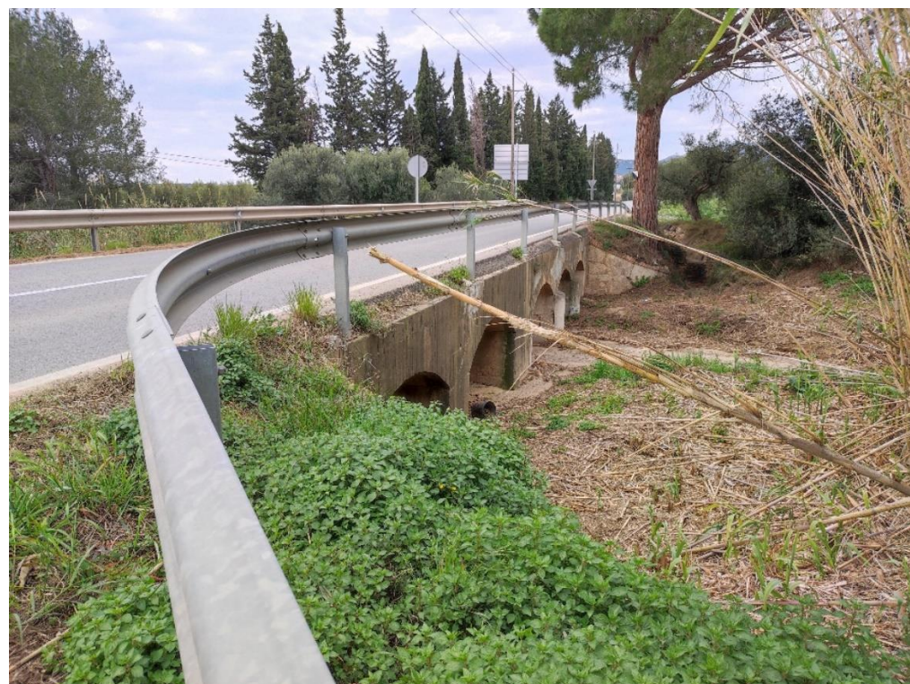
Figura 4. Estructura existent sobre el Barranc de l'Olivera, al PK 13+800 de la T-310z
