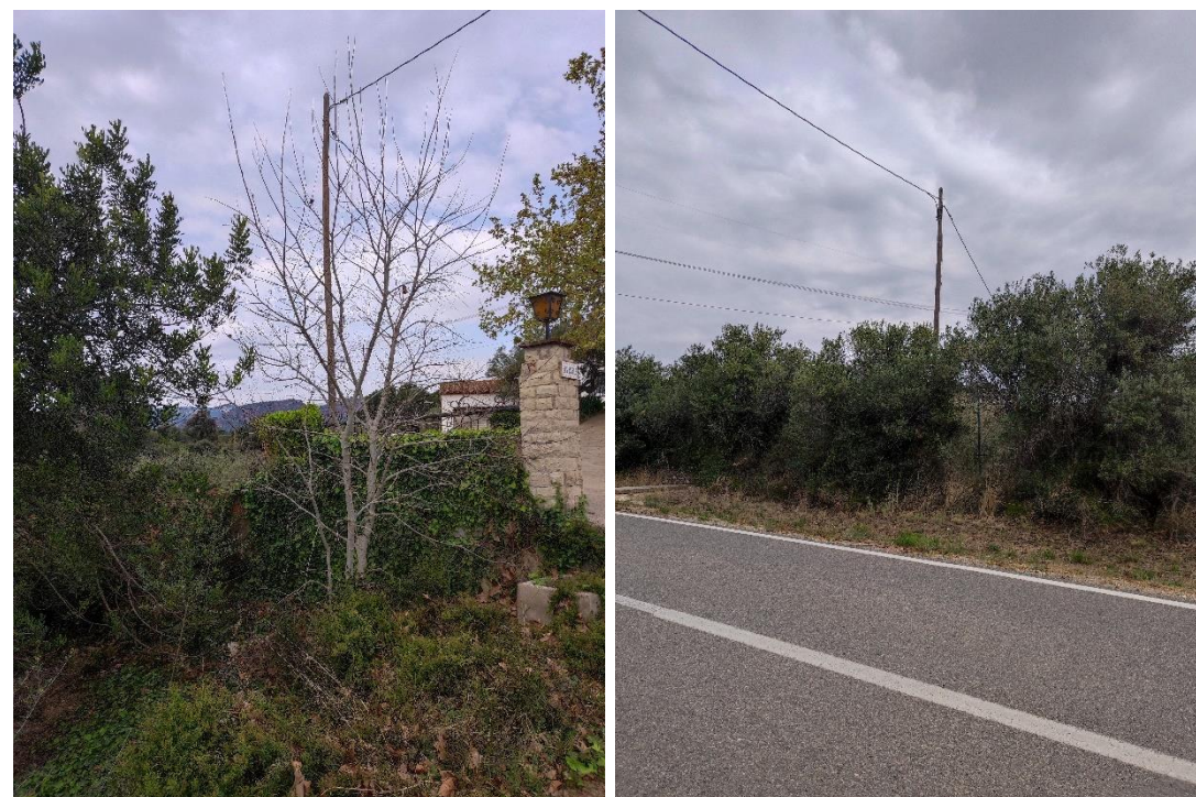
Figura 2. Servei existent núm. 102. Línia aèria BT, Endesa. PK 0+941
