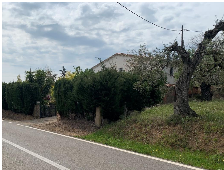
Figura 5. Servei existent núm. 108. Línia aèria BT, Endesa. PK 1+479
