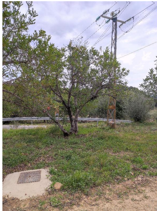
Figura 15. Servei existent núm. 301. Arqueta d'aigua potable, Ajuntament de Vilanova d'Escornalbou. PK 1+040
