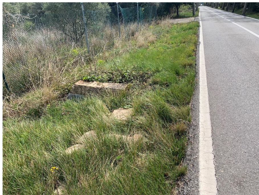
Figura 22. Servei existent núm. 503. Pou de la xarxa de reg, Comunitat de Regants de la Mina del Pont. PK 1+445
