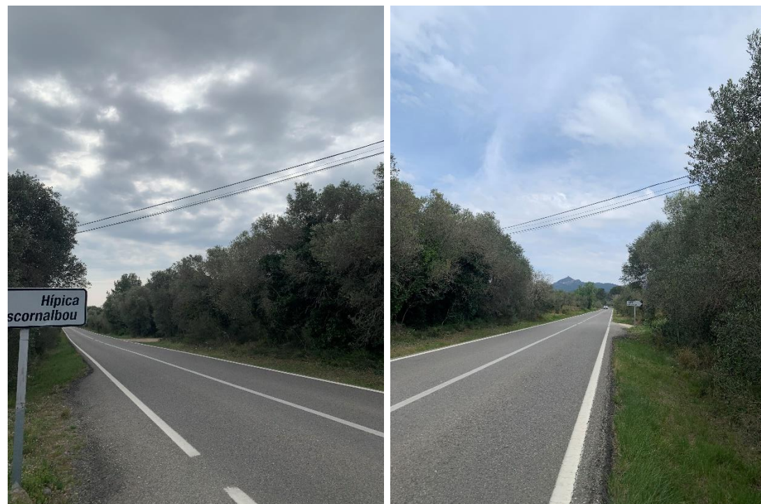
Figura 11. Servei existent núm. 202. Línia aèria, Telefónica. PK 1+726
