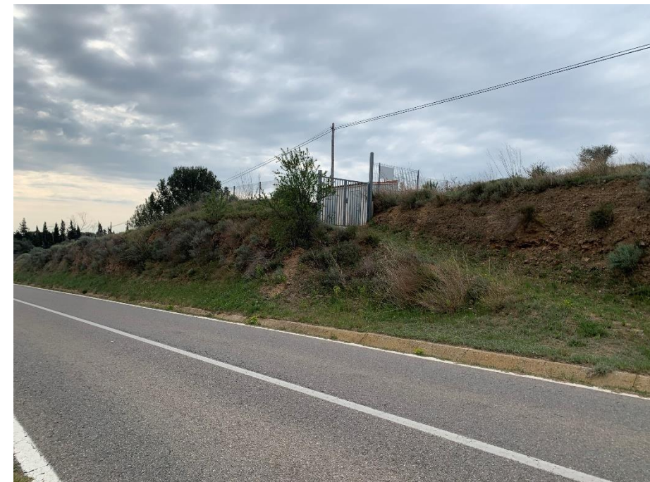
Figura 18. Servei existent núm. 304. Dipòsit d'aigua, Ajuntament de Vilanova d'Escornalbou. PK 2+548
