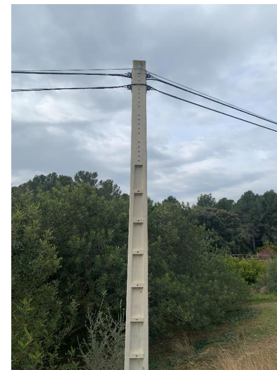
Figura 13. Servei existent núm. 202. Línia aèria, Telefónica. PK 2+157
