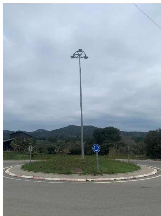
Figura 30. Servei existent núm. 602. Bàcul d'enllumenat, Ajuntament de Vilanova d'Escornalbou. PK 2+698
