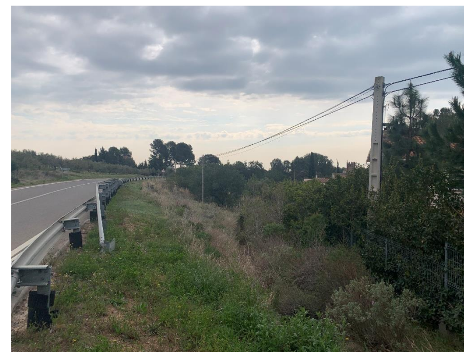
Figura 14. Servei existent núm. 202. Línia aèria, Telefónica. PK 2+240
