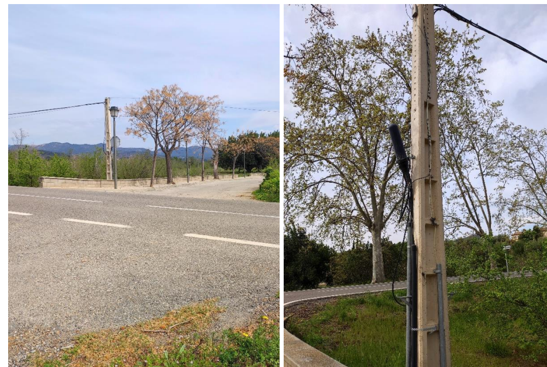
Figura 10. Servei existent núm. 202. Línia aèria, Telefónica. PK 1+334
