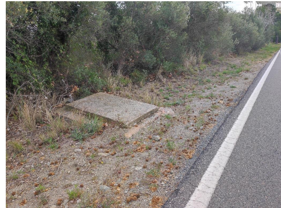
Figura 20. Servei existent núm. 501. Pou de la xarxa de reg, Comunitat de Regants de la Mina del Pont. PK 0+944
