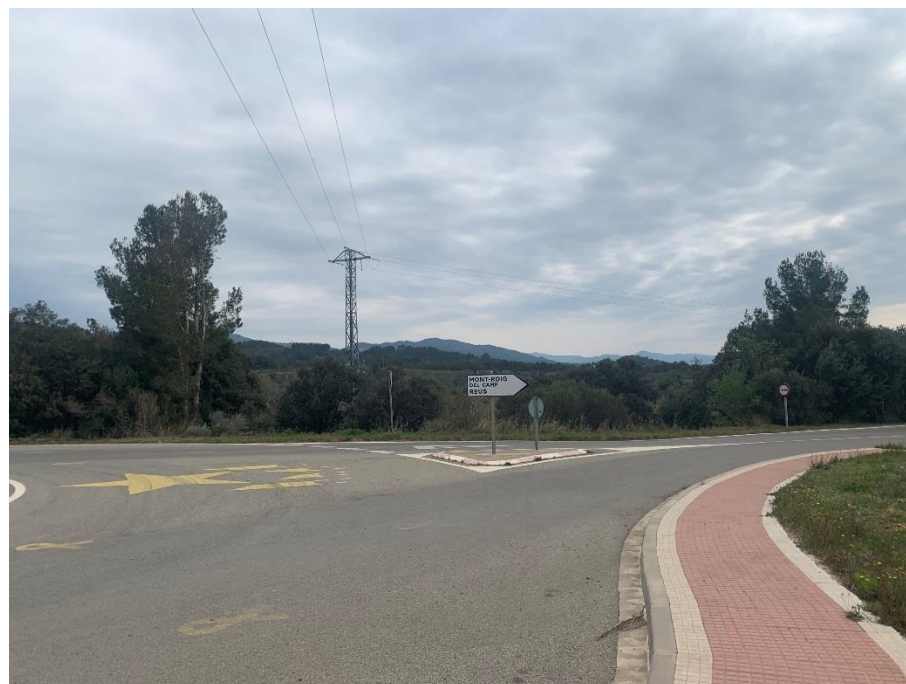
Figura 8. Servei existent núm. 114. Línia aèria MT, Endesa. PK 2+698
