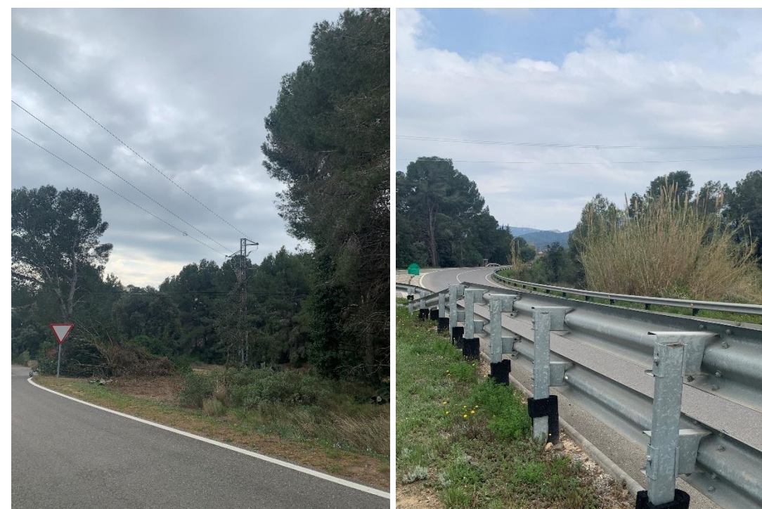
Figura 7. Servei existent núm. 113. Línia aèria MT, Endesa. PK 2+270
