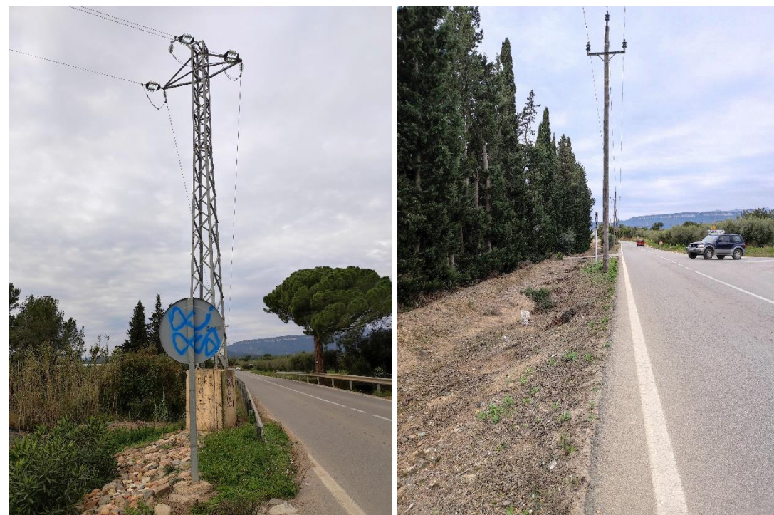
Figura 1. Servei existent núm. 101. Línia aèria MT, Endesa. PK 13+760 a PK 13+898 (eix 11)
