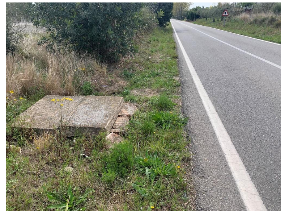
Figura 24. Servei existent núm. 505. Pou de la xarxa de reg, Comunitat de Regants de la Mina del Pont. PK 1+542
