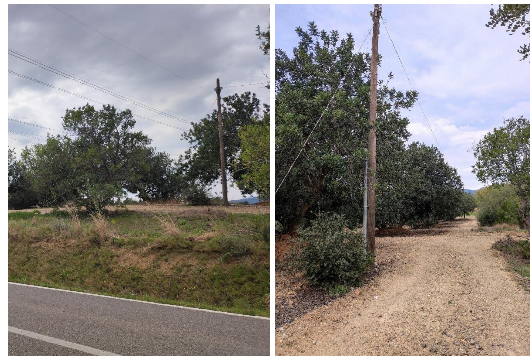
Figura 9. Servei existent núm. 202. Línia aèria, Telefónica. PK 1+011
