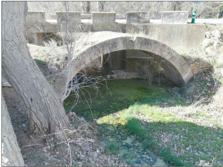
FOTOGRAFIA CALAIX I ARC VISTA AIGÜES AVALL
