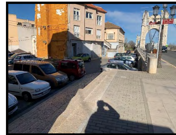
Foto 16. Ubicació de la rampa nord adossada al pont de l'Ebre a Amposta
