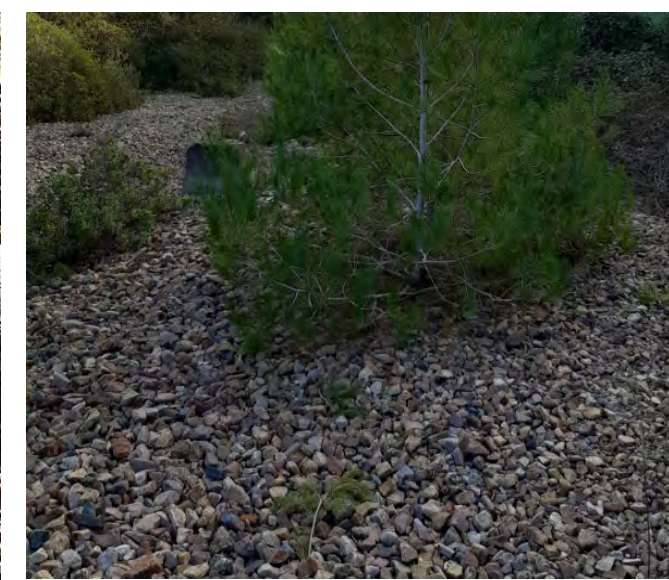
Capa de balast de gran gruix amb vegetació arbòria
