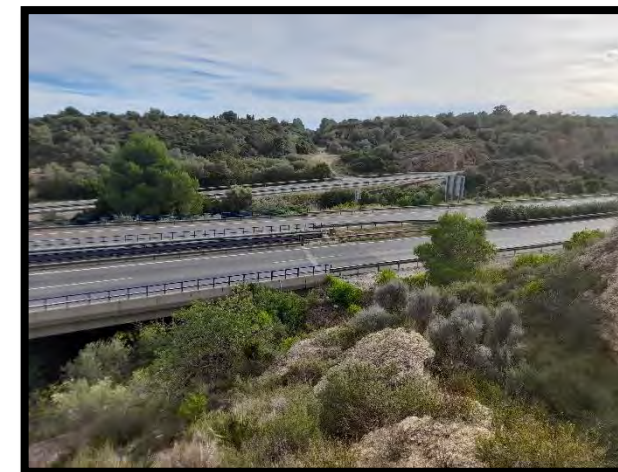
Foto 12. Autovia AP-7 i carretera C-12
