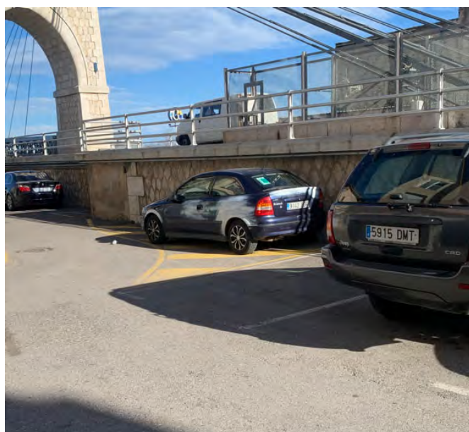
Desnivell Rampa Nord
