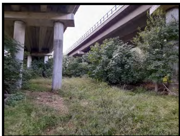
Foto 13. Zona de fonamentació de la pila P-1 de la passarel·la sobre l'autovia AP-7
