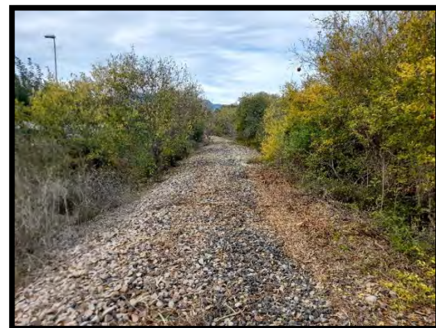
➤ Foto 2. Tram amb balast
