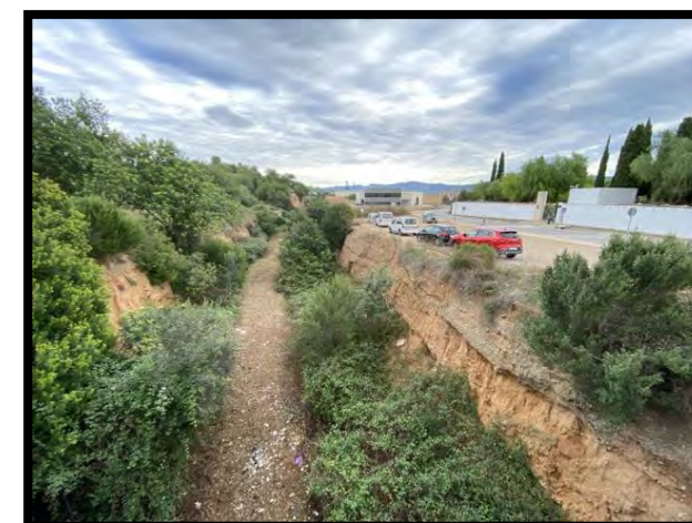
➤ Foto 4. Zona de terraplè en Raval de Crist
