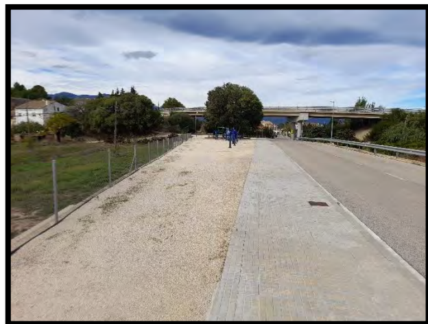
Foto 9. Tram d'instal·lació de fanals en Vinallop
