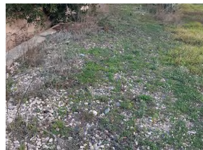
Superfície amb presència de balast semi enterrat
