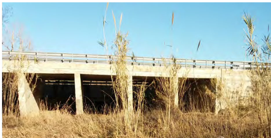
Imatge de l'actual pas del barranc de la Galera sota la C-12. L'alternativa 2 suposaria perllongar aigües amunt aquesta solució.
