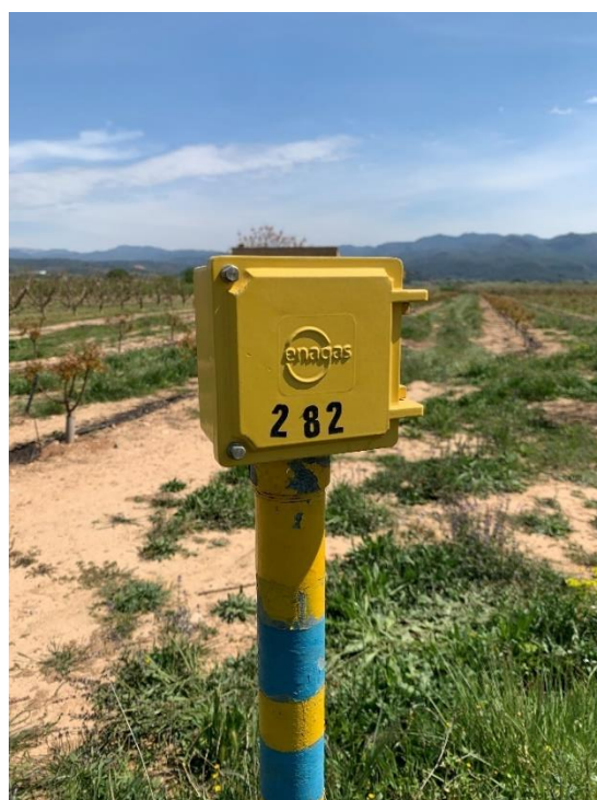
Il·lustració 6. Servei existent 701 de gas al PK 19+380
