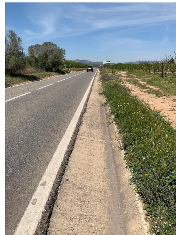
Figura 11. Vista general del vial i cuneta de formigó a la vorera dreta al PK 19+420
