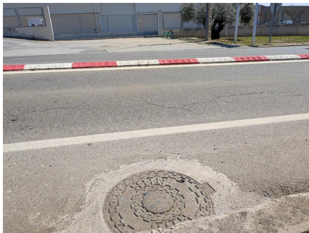
Il·lustració 18. Servei existent 406, pou de registre a la T-324 a l'alçada PK 20+512
