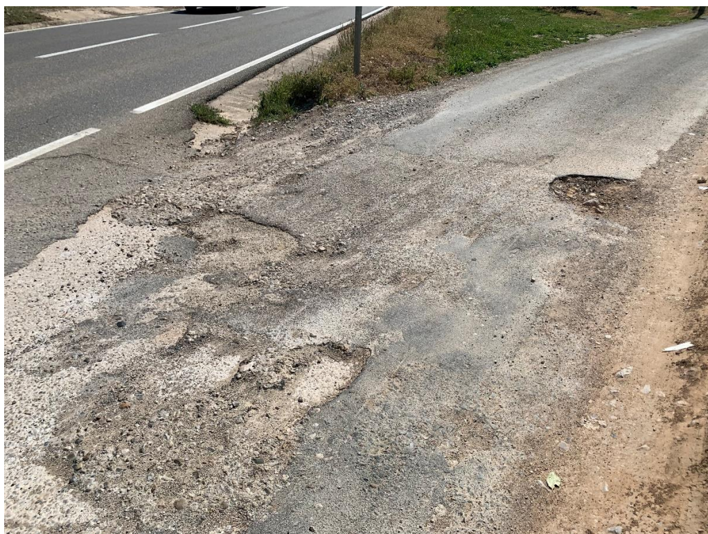
Figura 14. Estat del ferm d'una sortida localitzada a la vorada esquerra del T-324 al PK 19+660
