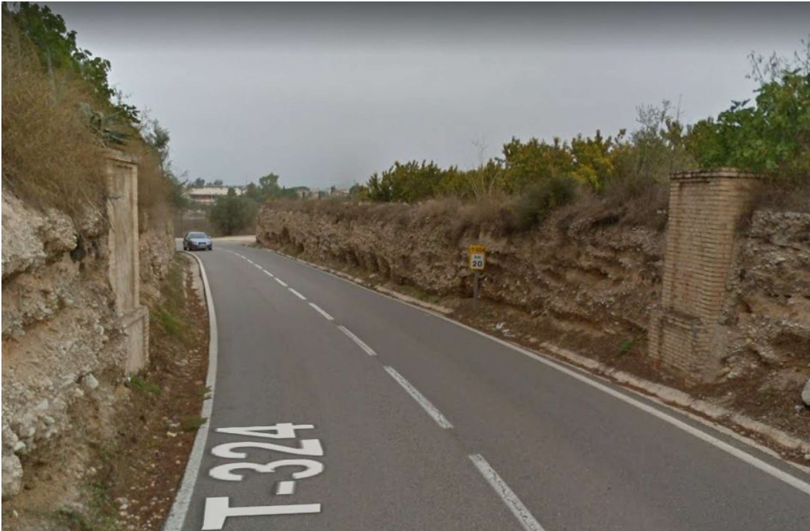
Infraestructura comunitat de regants de Mora d'Ebre
