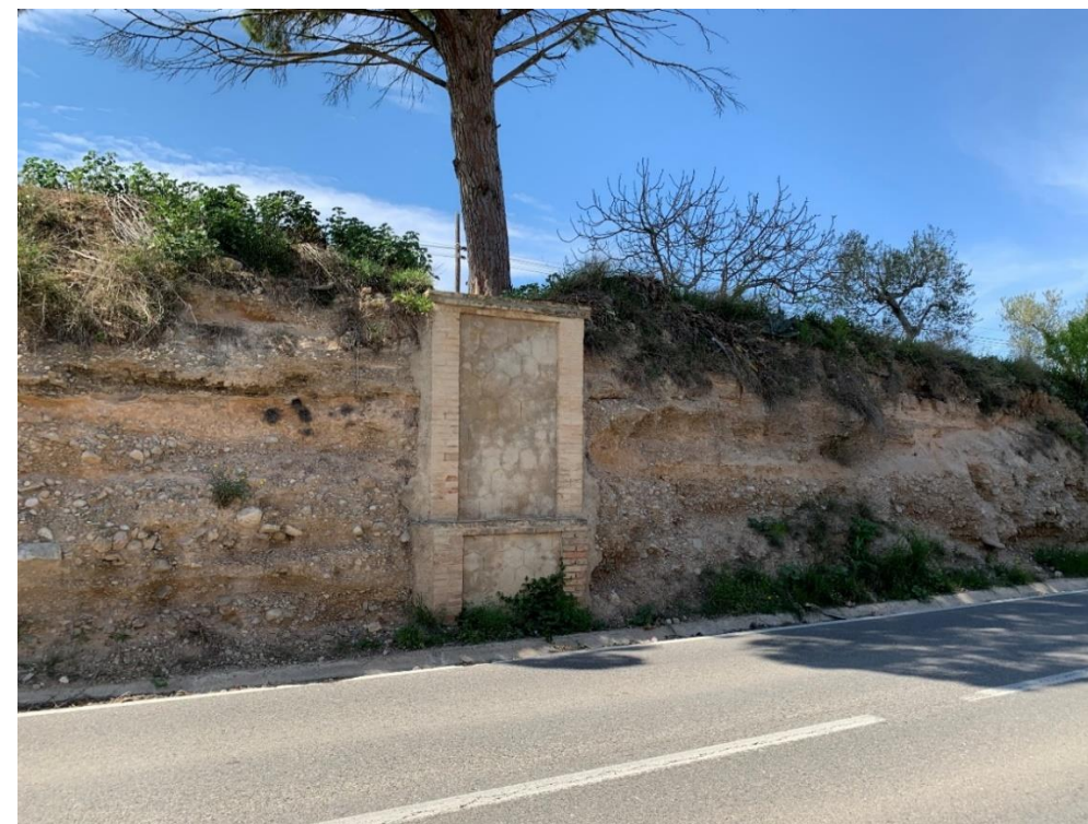
Il·lustració 11. Servei existent 503, obra de formigó per línia de reg al marge esquerre al PK 20+018
