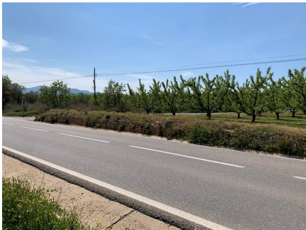
Figura 13. Tancament molt proper al marge esquerre de la T-324, a l'alçada PK 19+490
