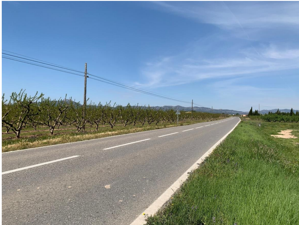
Figura 5. Vista general de la T-324 a l'alçada PK 18+740
