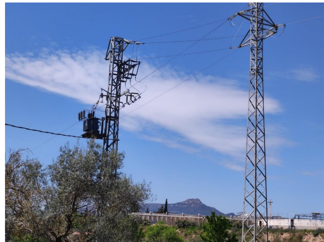
Il·lustració 15. Servei existent 108, torres metàl·liques localitzades al marge esquerre al PK 20+320
