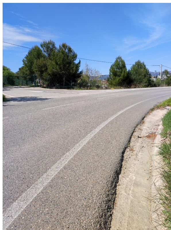
Il·lustració 14. Servei existent 102 discorrent per la vorera esquerra al PK 20+160
