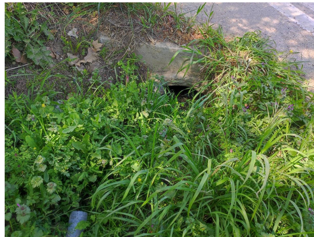
Figura 19. Detall de la cuneta de la vorera esquerra al PK 20+140
