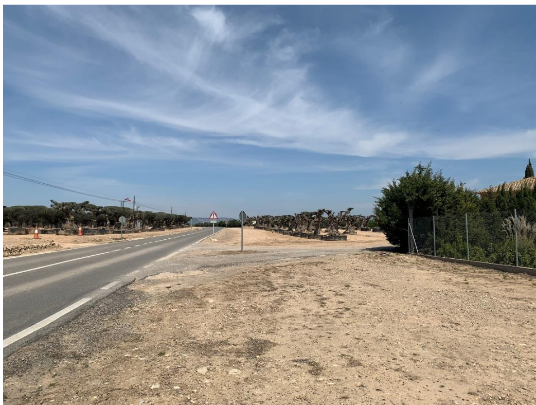
Figura 2. Marge dret a l'inici del tram d'estudi. PK 18+560
