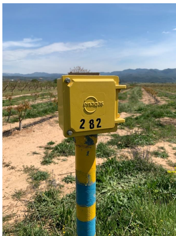
Figura 10. Instal·lació del servei de gas Enagas al PK 19+380
