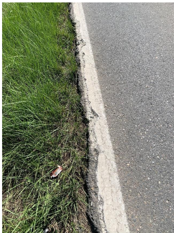
Figura 9. Detall del límit de la carretera T-324 al PK 19+350
