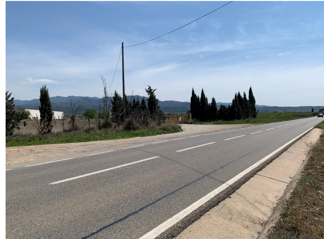
Figura 7. Línia aèria de telefonia creuant la traça de la T-324 al PK 19+050
