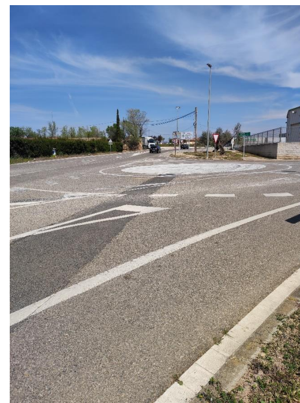
Figura 24. Intersecció entre la carretera T-324 i el carrer Verdeguera-Riu Sec. PK 20+460
