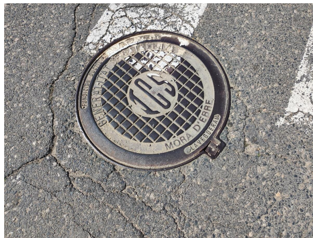
Il·lustració 16. Servei existent 404, pou de registre al carrer Verdeguera-Riu Sec
