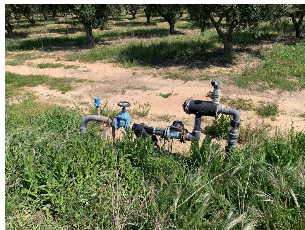
Figura 4. Instal·lació de reg al marge dret al PK 18+817
