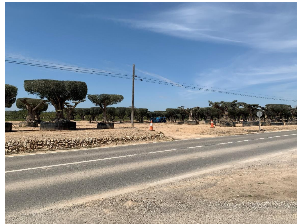
Figura 3. Línia aèria de telefonia sobre pals de fusta, al marge dret de la T-324 al PK 18+580
