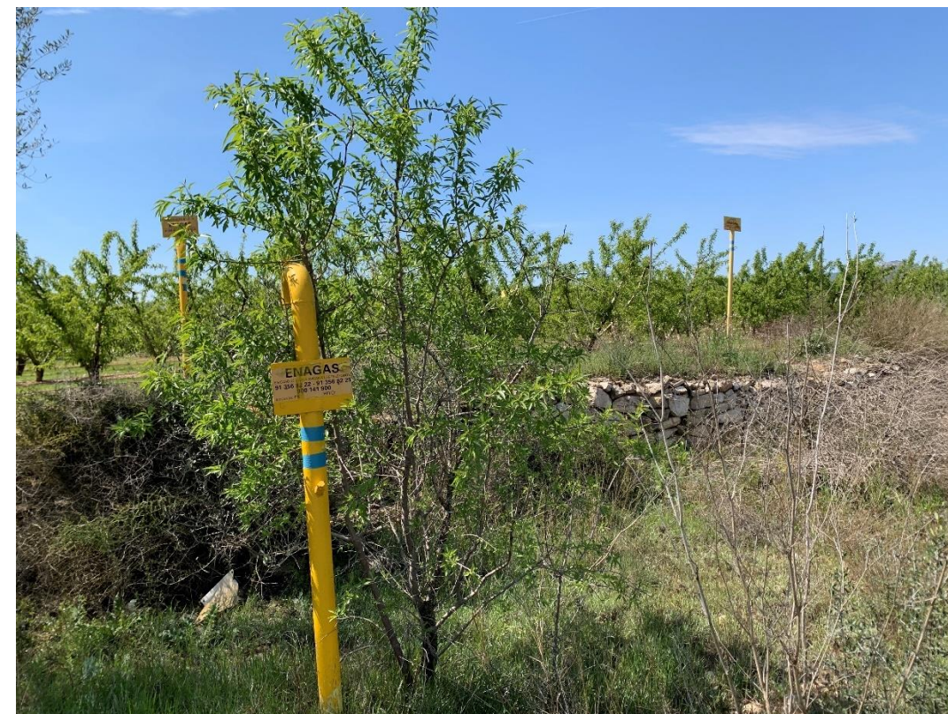
Il·lustració 7. Servei existents 701 i 702 de gas al PK 19+385
