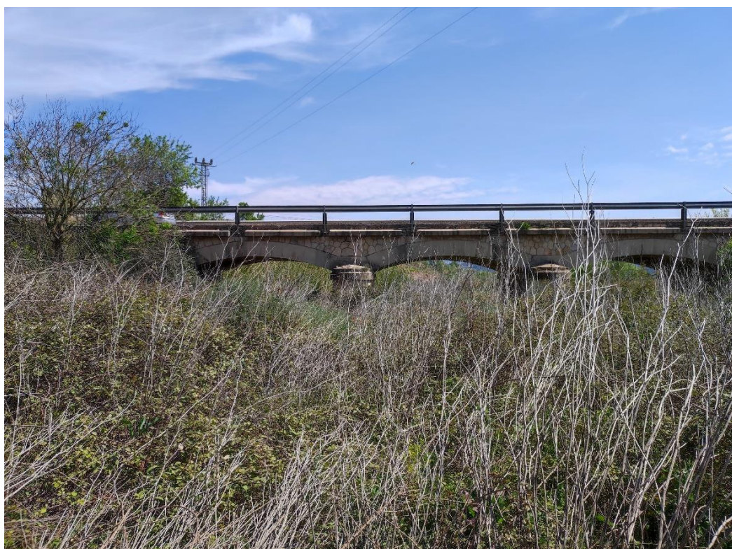
Figura 22. Obra de fàbrica al PK 20+330
