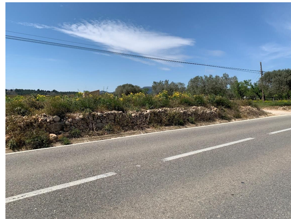
Figura 15. Mur de pedra pròxim al marge esquerre de la T-324 al PK 19+835
