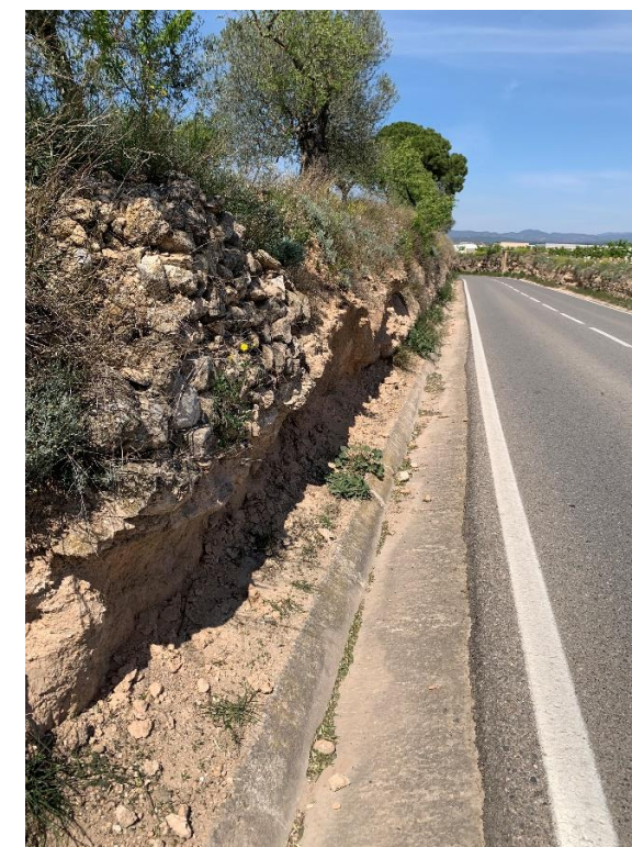
Figura 16. Cuneta de formigó al marge esquerre de la T-324 al PK 19+940
