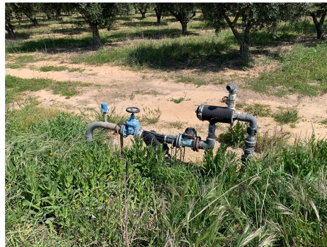
II·lustració 3. Servei existent 501, instal·lació de reg a la vorera dreta al PK 18+812
