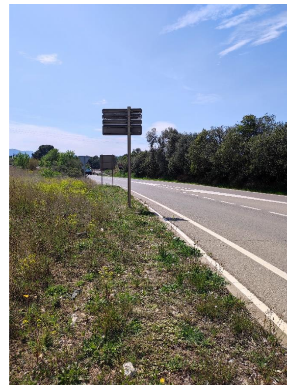
Figura 23. Vista general del vial al PK 20+380
