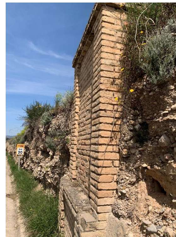
Il·lustració 12. Servei existent 503, obra de formigó per línia de reg al marge dret al PK 20+018
