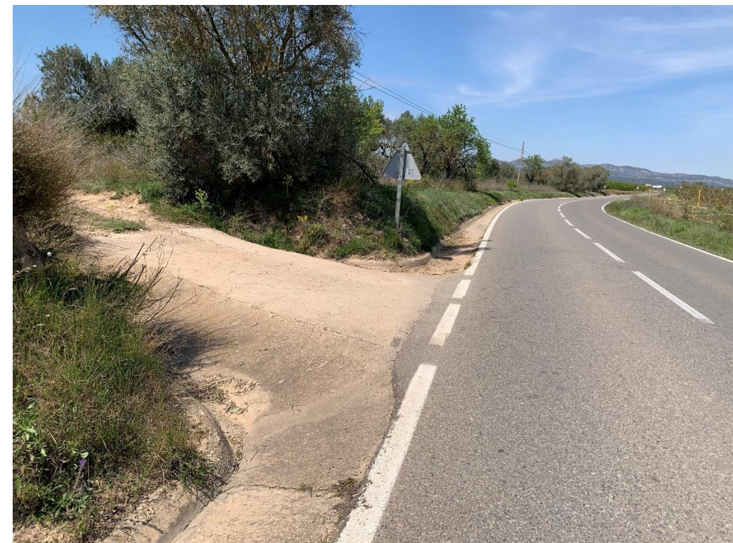
Figura 8. Rampa de formigó al marge esquerre del vial al PK 19+120
