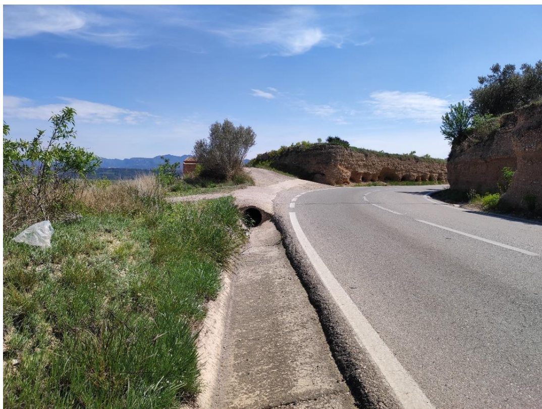
Figura 18. Cuneta de formigó al PK 20+120
